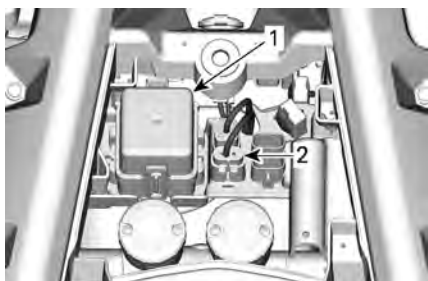
1. Boîte à fusibles avant
